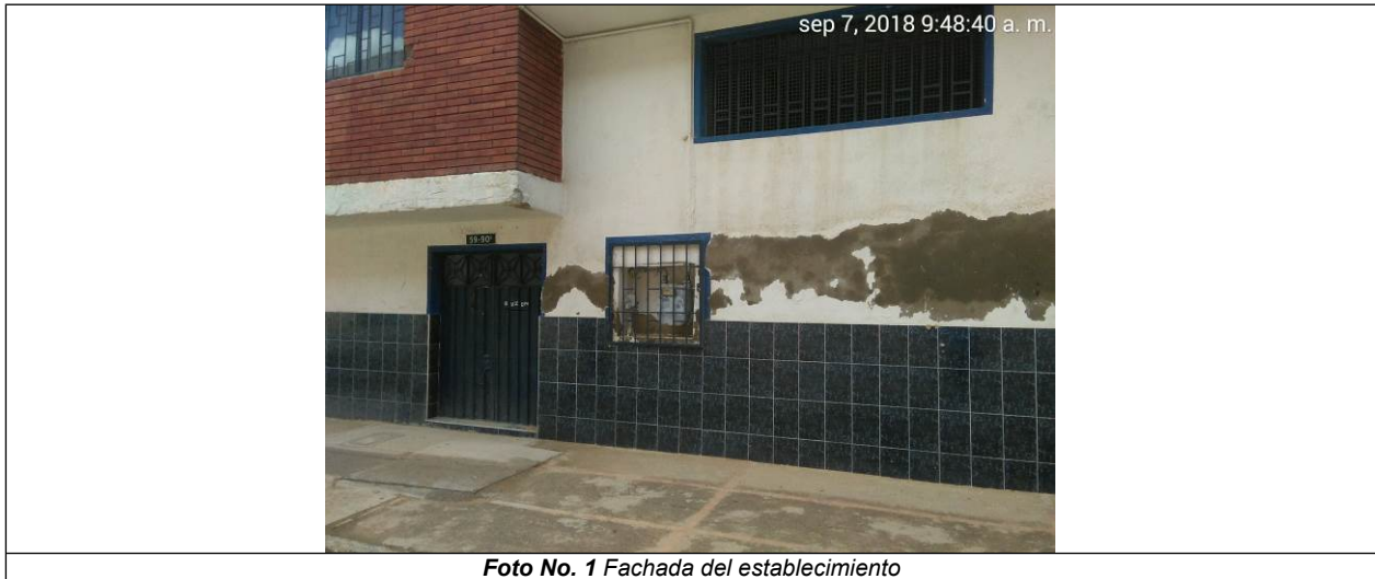
Foto No. 1 Fachada del establecimiento
